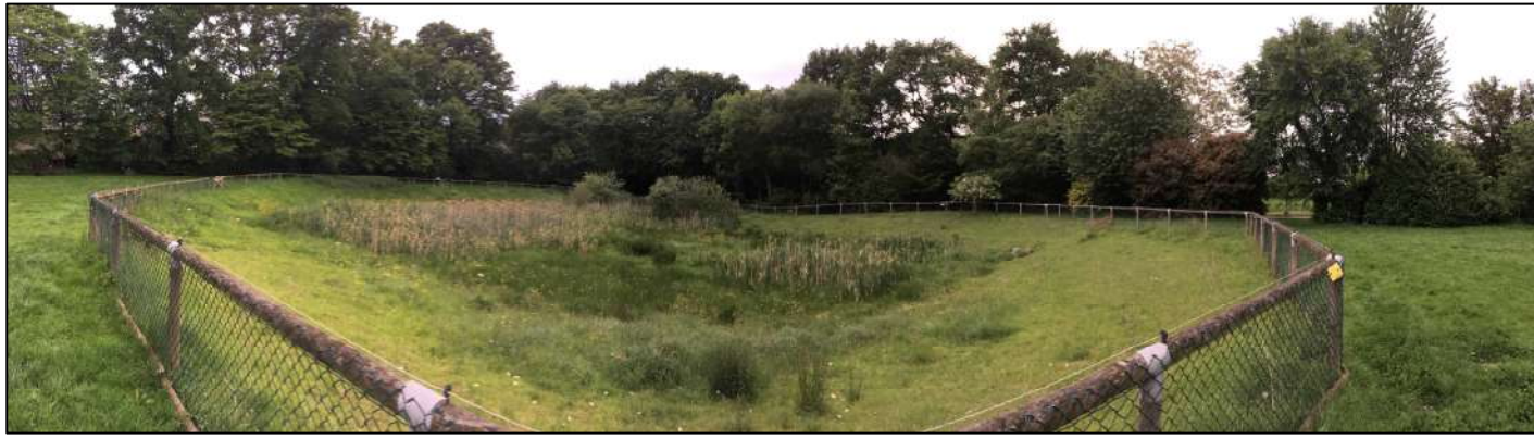
Photo 30: ouvrage de rétention/régulation - IAO SENN - 2017
